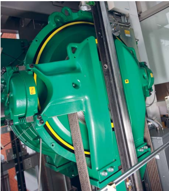
Энергосберегающий подъемный механизм KONE EcoDisc®.
