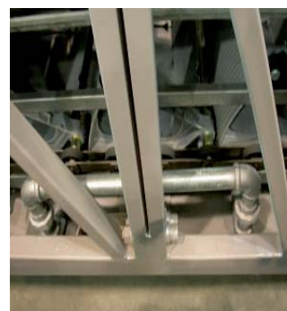
Спринклерная система
