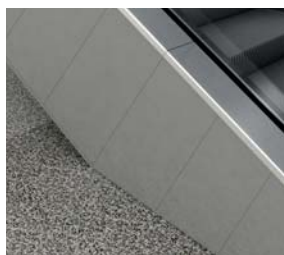
Облицовка из серой листовой стали с порошковым покрытием (RAL7036)*****
