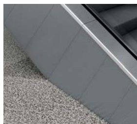
Облицовка из полированной листовой нержавеющей стали*****
